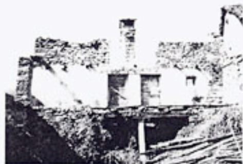
Das Bauprojekt in Gordevio/TI (1985/86): Die Ruine, der Alt-Neu-Bau, ein Blick in den Innenraum.
